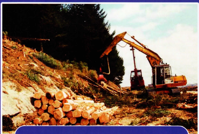
TAPIO 600 EXS JCB grävmaskin, Skyline vinsch Väggkant bearbetning i Skottland
